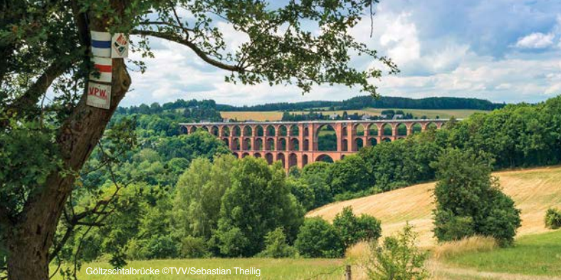
Göltzschtalbrücke ©TVV/Sebastian Theilig
