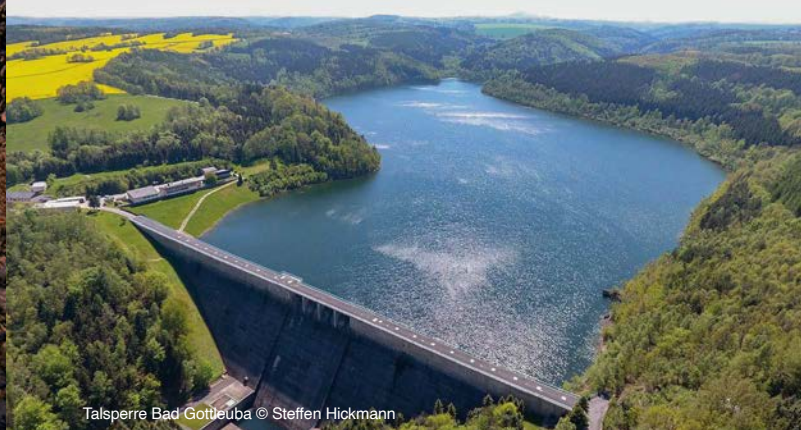
Talsperre Bad Gottleuba © Steffen Hickmann
