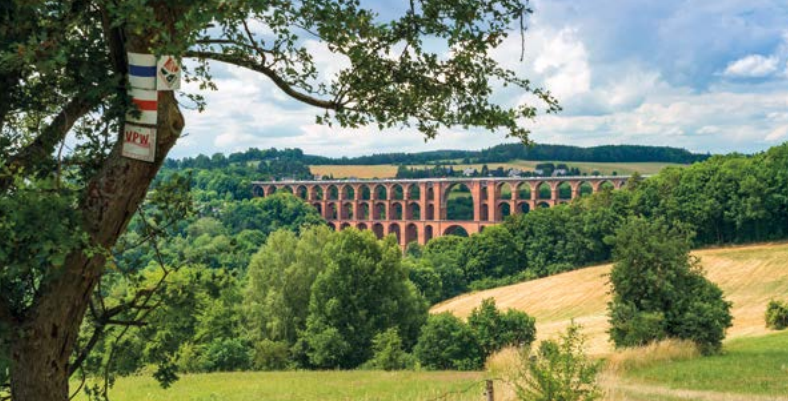
Göltzschtalbrücke ©TVV/Sebastian Theilig
